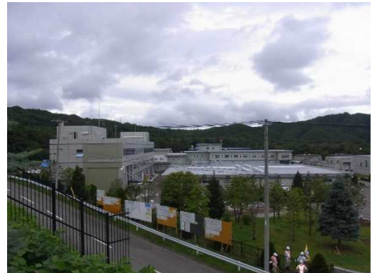
白川第2浄水場
