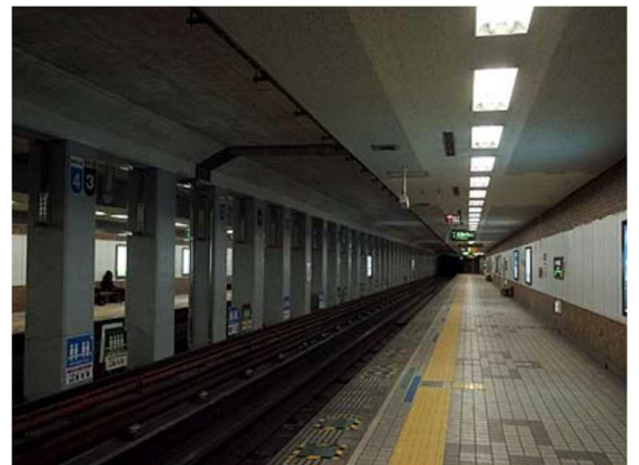
地下鉄中の島駅
