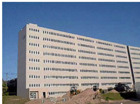
札幌市公営住宅
